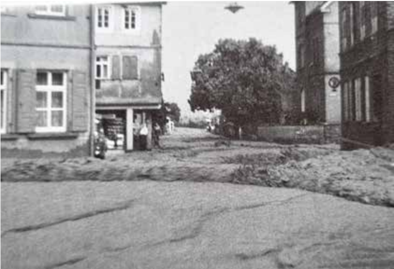
Hochwasser am 17.06.1966. Einmündung Rothenberger Straße in die Naheweinsteinstraße
