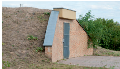
Der Tiefbrunnen Sonnenborn II zwischen Langenlonsheim und Laubenheim
