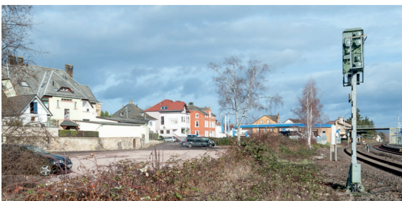
Neuer Zugang zu den Gleisen über das Gelände der abgerissenen „Alten Bahnschlosserei“
