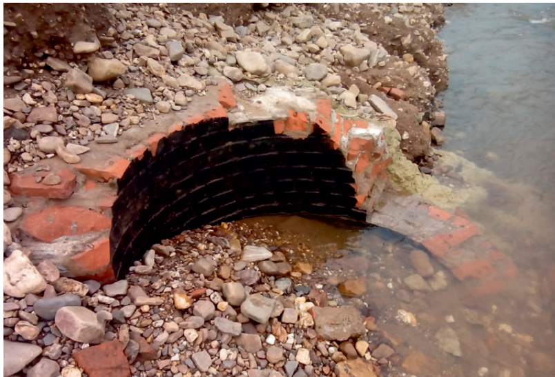
Durch das Hochwasser 2016 freigespülter alter Brunnen am Ufer des neuen Bachs im Poldergebiet an der Nahe
