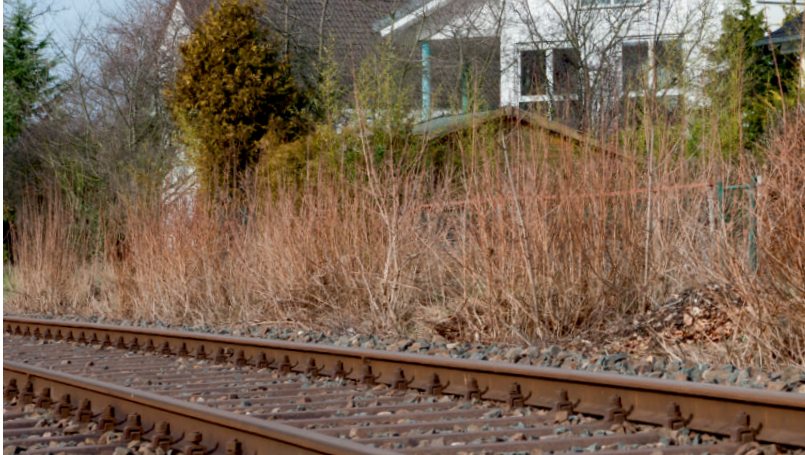
Wohngebiet „Unterster Pfeiffer 3“ an der Hunsrückbahn
