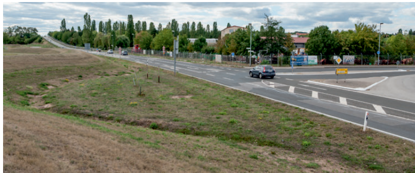
Die Einbuchtung des „Riegeldeichs“ an der Einmündung zum Industriegebiet
